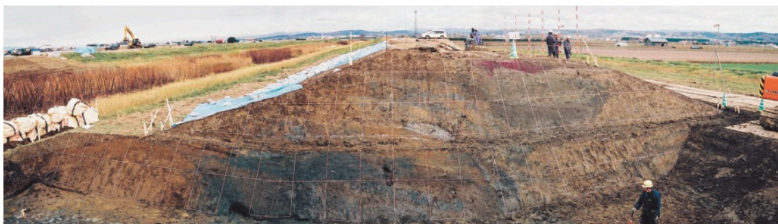
写真 2.3.9-2 清真布川左岸堤防の開削断面 (堤体沈下状況と液状化による噴砂痕跡が判別できる)
