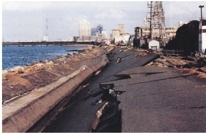
写真 2.3.8-1 淀川堤防の災害状況（左岸堤防を上流向きに撮影）
