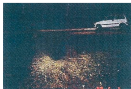
② 天端の舗装が半ばまで欠けてきた
