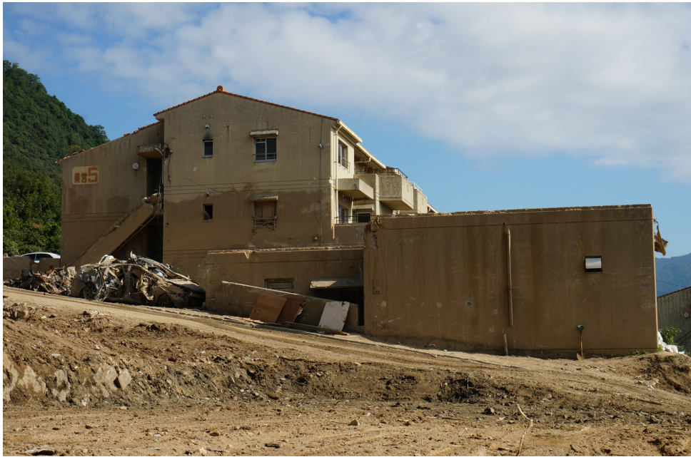
図3 土石流が衝突した鉄筋コンクリート構造の県営住宅
