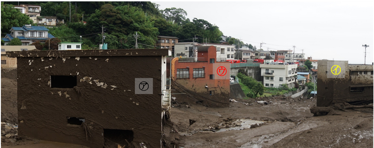
図5 泥流が衝突した鉄筋コンクリート構造の建物
