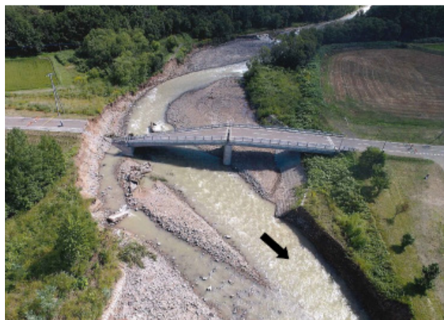
図-1 流路変動による橋台被災の例
