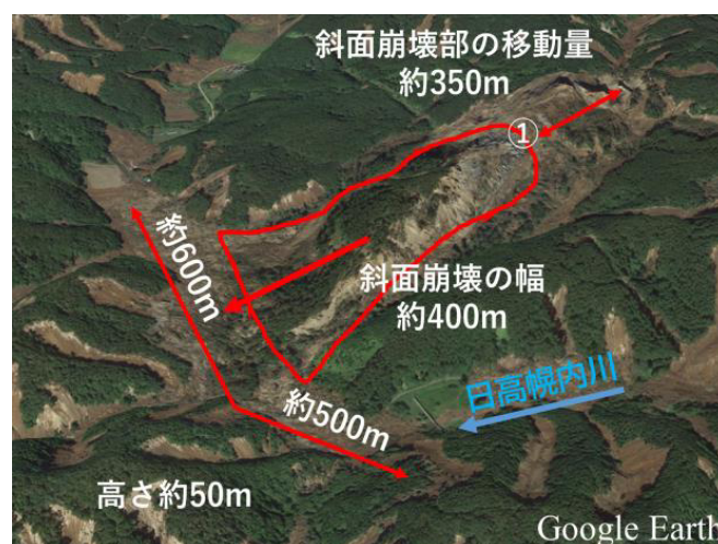
図9-1 日高幌内川の天然ダムを形成した斜面崩落状況
