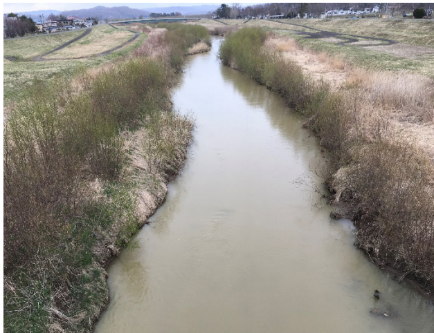
写真6-3 厚真大橋付近の状況
