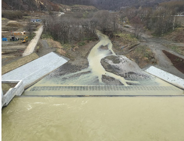
写真6-1 厚幌ダム放出路状況
