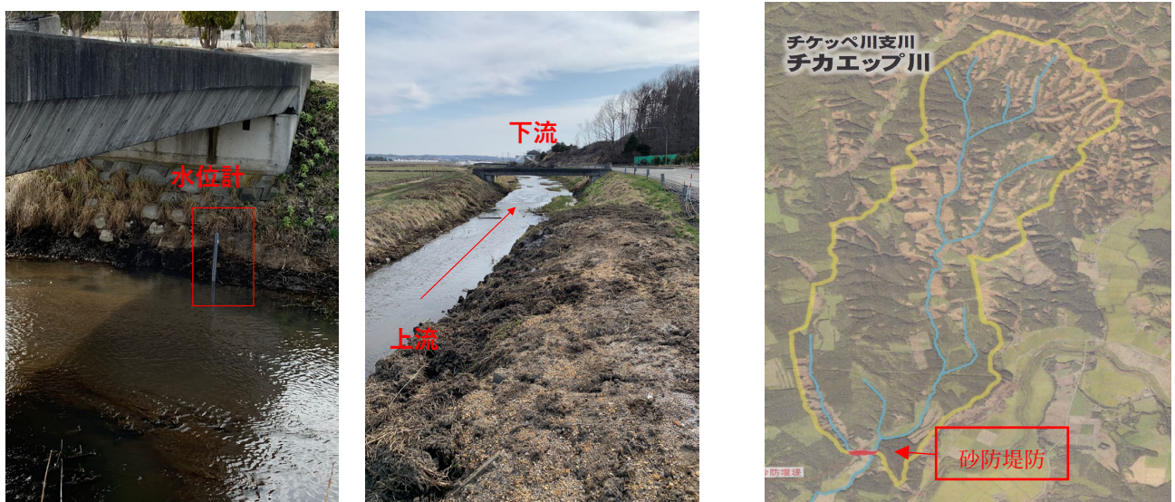
写真5-2 水位計の設置場所（左）と周辺の様子（右）
