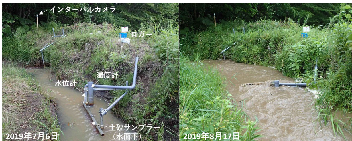
図4-2 流出観測点での観測機材設置状況（左図）と出水時の状況（右図）
