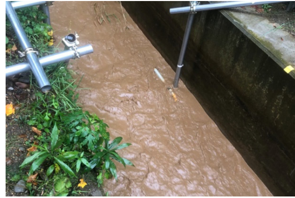
図3-19 出水で浸かった濁度計
