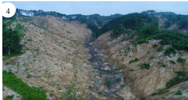
図3-8 支川最上流部の土砂崩壊面
