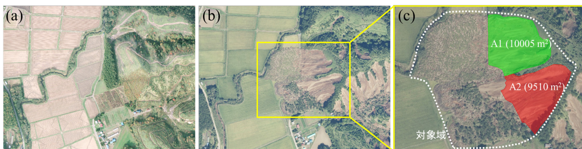
図2-12 対象斜面の崩壊前後の航空写真（国土地理院）． (a) 崩壊前(2016年度)，(b) 崩壊後(2018年9月7日撮影)，(c) 対象域と対象斜面（A1とA2）
