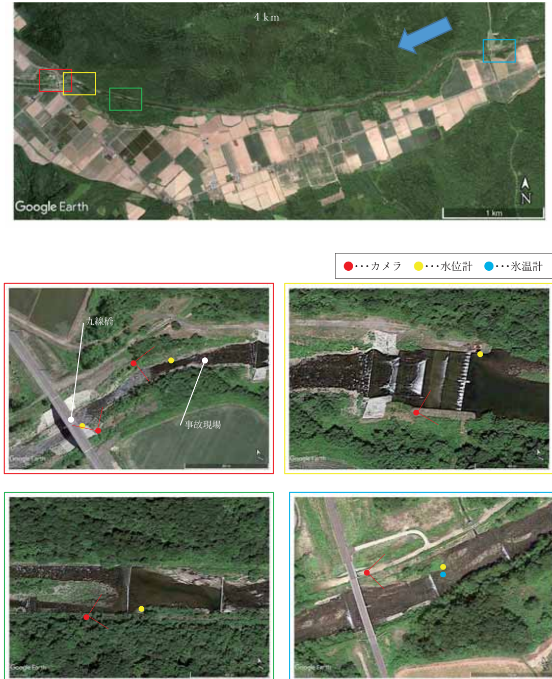
図-3.1 辺別川における機器設置場所
