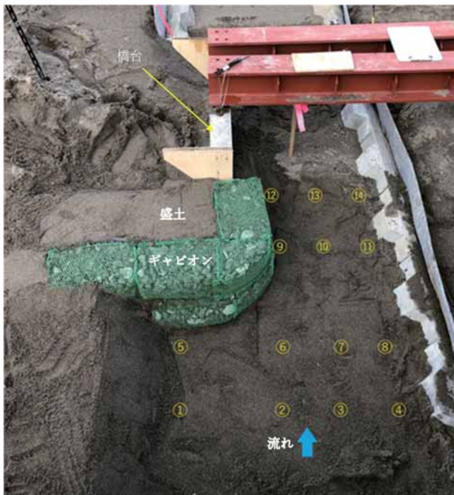
図16 通水前の橋台周辺の状況
