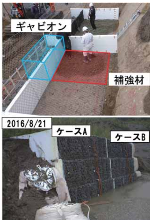
図8 ギャビオン補強土壁の試験施工例 5),6)
