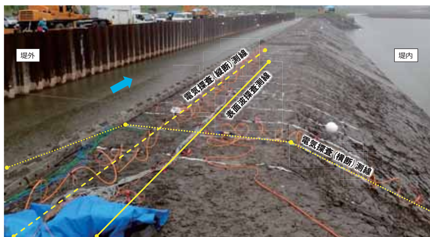
図18 実験堤防および物理探査測線の状況
