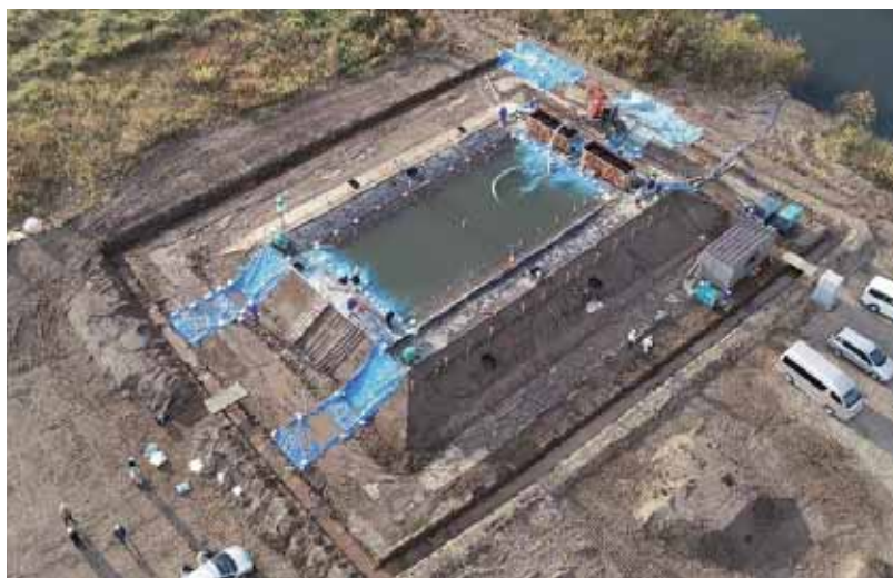
図31 実物大試験堤防の実験状況
