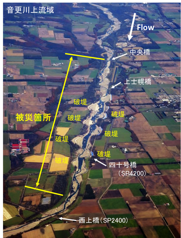
図-2 2016年北海道豪雨災害における音更川上流域の被災状況（上士幌観測所より上流域）
