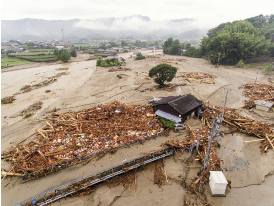
図1 流木の橋梁上流側のスタックの例（2017年九州北部豪雨災害）
