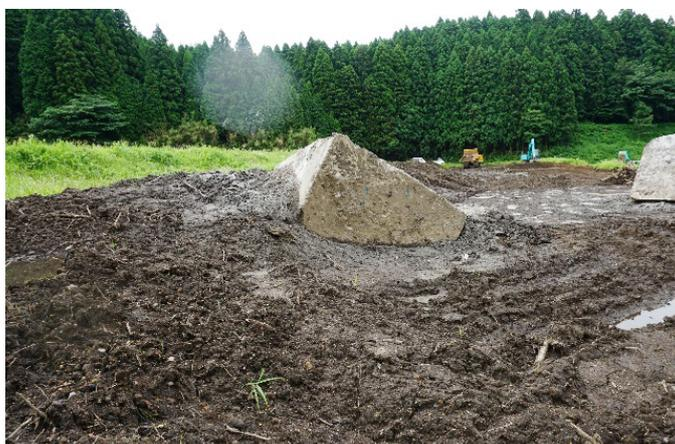
図14 破壊された砂防ダム右岸側の袖部
