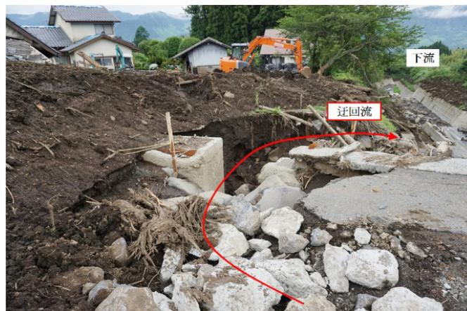
図10 迂回流による河岸の浸食
