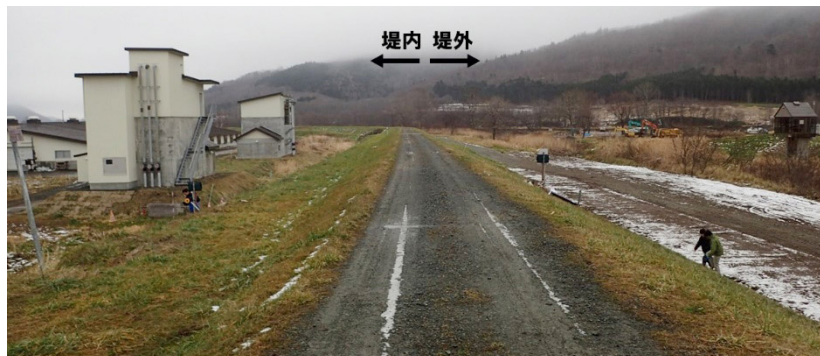
図22 動態観測箇所の状況(KP24.6付近)
