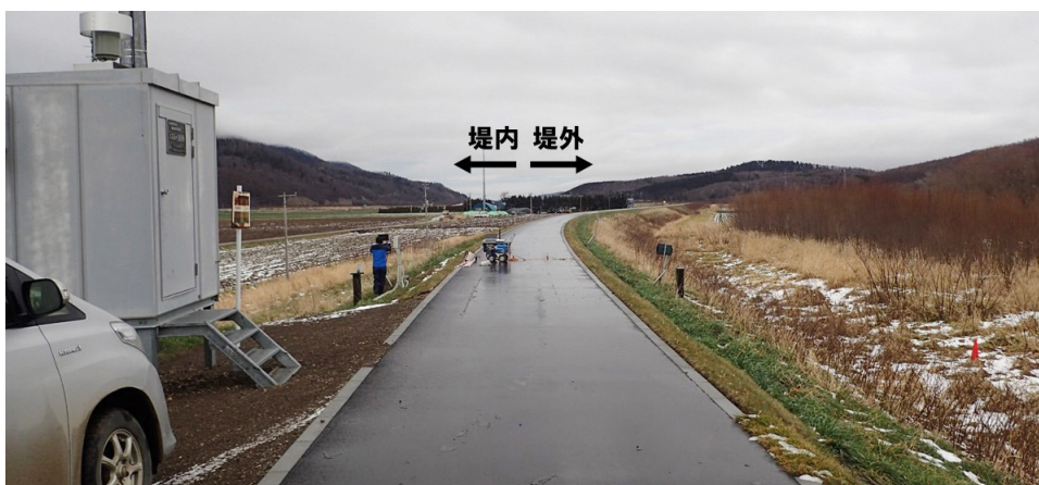
図5 動態観測箇所の状況 (KP18.6付近)
