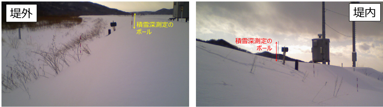
図8 2017年1月30日12:00における堤体のり面の状況
