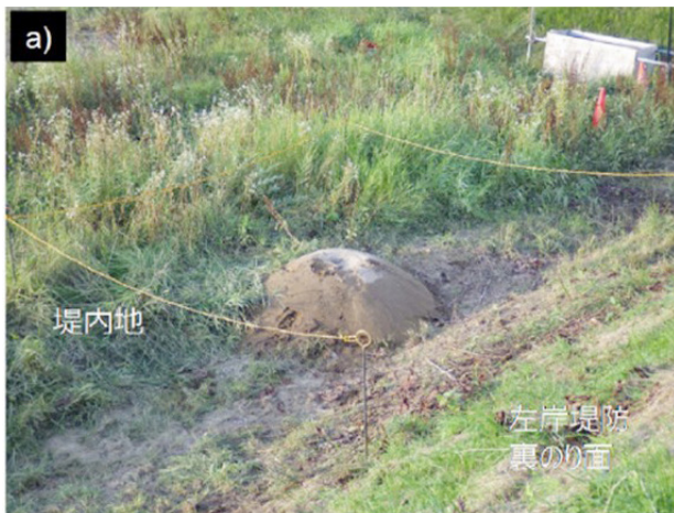
図4 噴砂発生状況 (左：堤体から撮影，右：噴砂の形状と大きさ)
