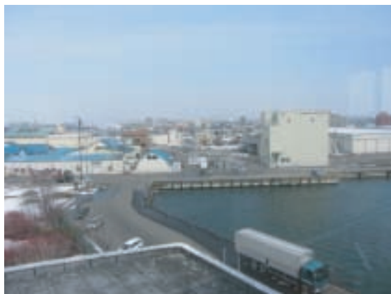
図-6 橋北西部地区全景
