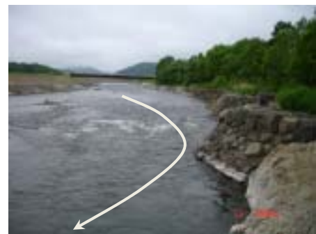
写真-4 蛇行部 左岸の石組み水制群
