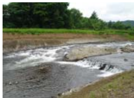
写真-1 河道の基岩露出部
