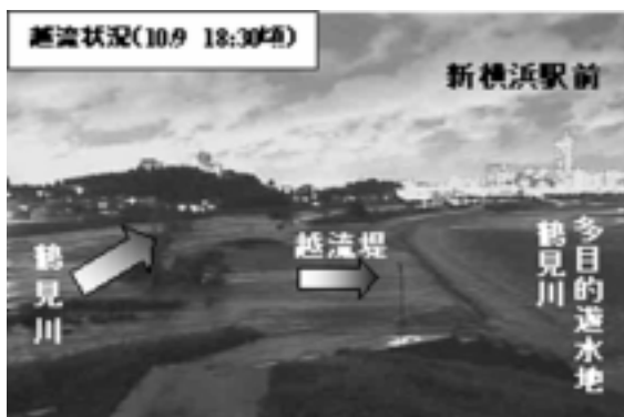
写真-3 ピーク水位付近の越流状況
