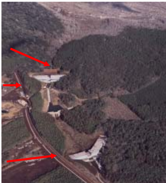
写真-7 雲仙普賢岳に施工された火砕流熱風部対策用の柵工(矢印)
