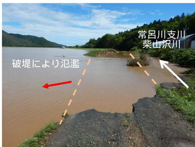
写真1 破堤箇所現地写真
