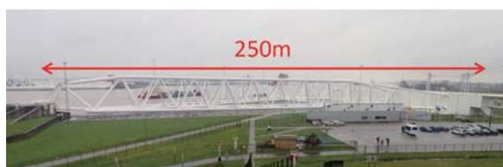
図参2-8 マエスラント高潮堰(2018年1月10日撮影, 片翼の幅210m, 回転半径250m)
