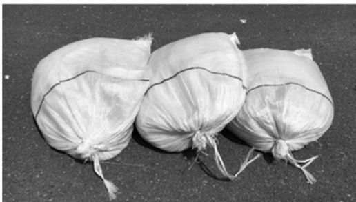
小口（こぐち）積み 土のうの長辺が重なるように積みます
