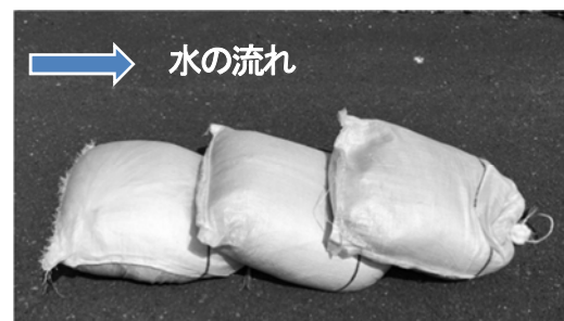
長手（ながて）積み 土のうの短辺が重なるように積みます 土のう底部を上流に向けます
