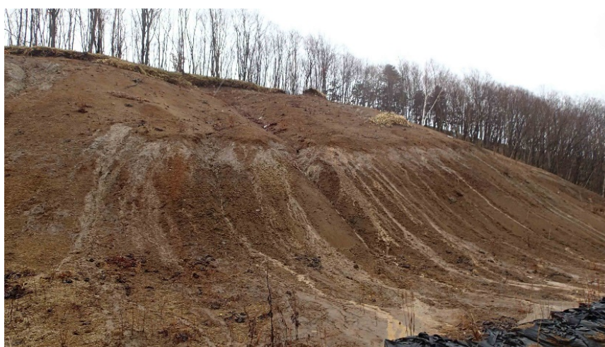
図13 降雨イベントでの裸地斜面からの土砂流出（2023年3月10日）
