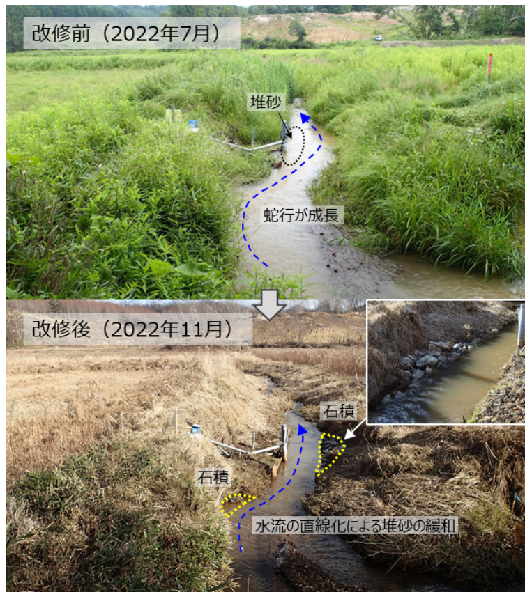
図3 流出観測サイトでの簡易改修工事（自然石と土のうを用いた護岸による水流の直線化）前後の状況
