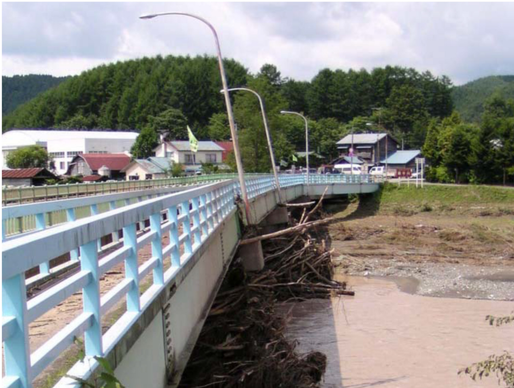
図1 橋脚による流木捕捉の例（2008年8月 額平川貫気別橋 1) ）
