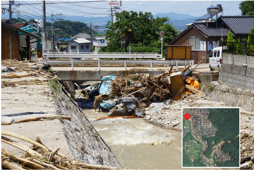
図8 天神交差点付近の橋梁
