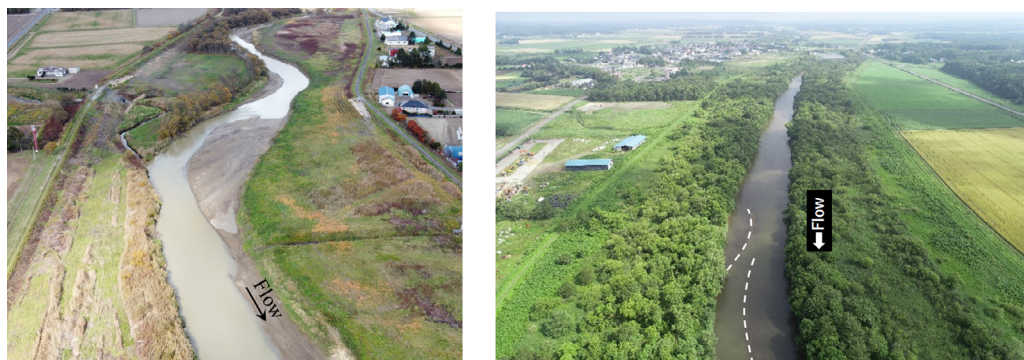
厚真川下流域の写真(KP6.4地点) (撮影日:2020/10/26, ドローン撮影)
