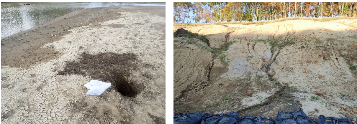
図-3 地点④の河床材料採集地点（左）および地点⑦の崩壊裸地斜面の表面侵食状態（右）
