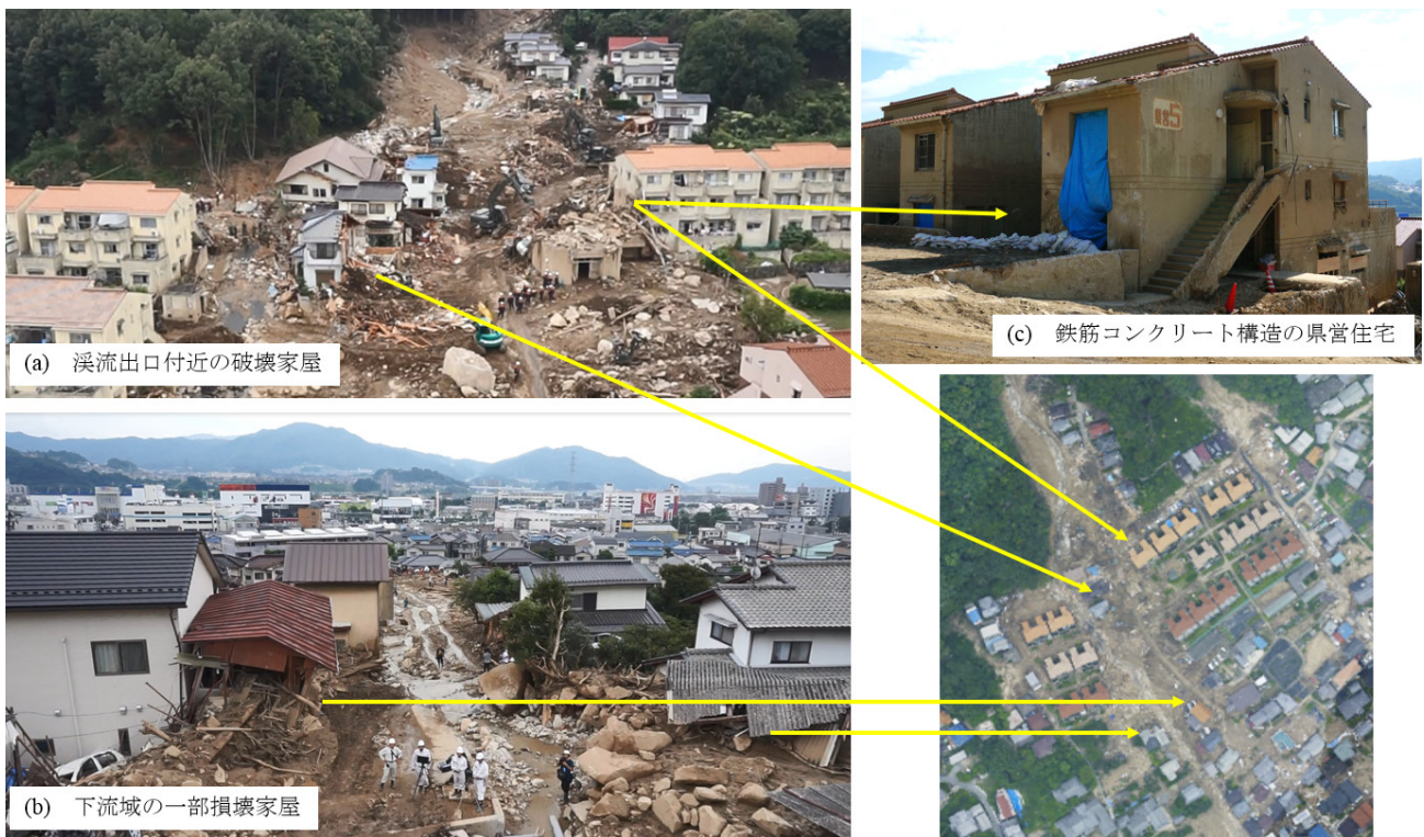
図4 家屋の破壊状況（(a)と(b)はルーチェサーチによる撮影）
