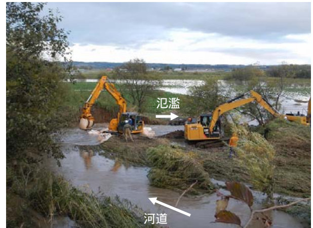
写真-1 破堤したサラカオーマキン川での締切作業 (2015.10.9 著者撮影)
