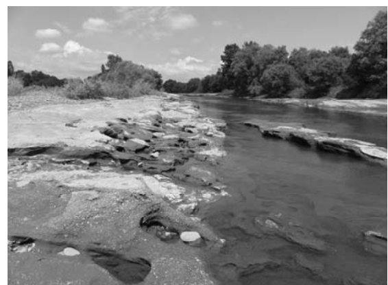
図-1 石狩川における岩盤侵食 (KP161.5km付近)
