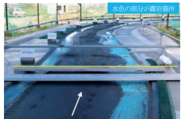
図-7 露岩状況 (KP162.0付近)
